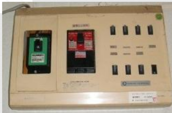
一般家庭の配電盤
